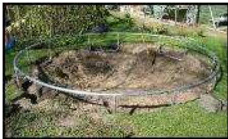
2. Frame waterpas plaatsen
